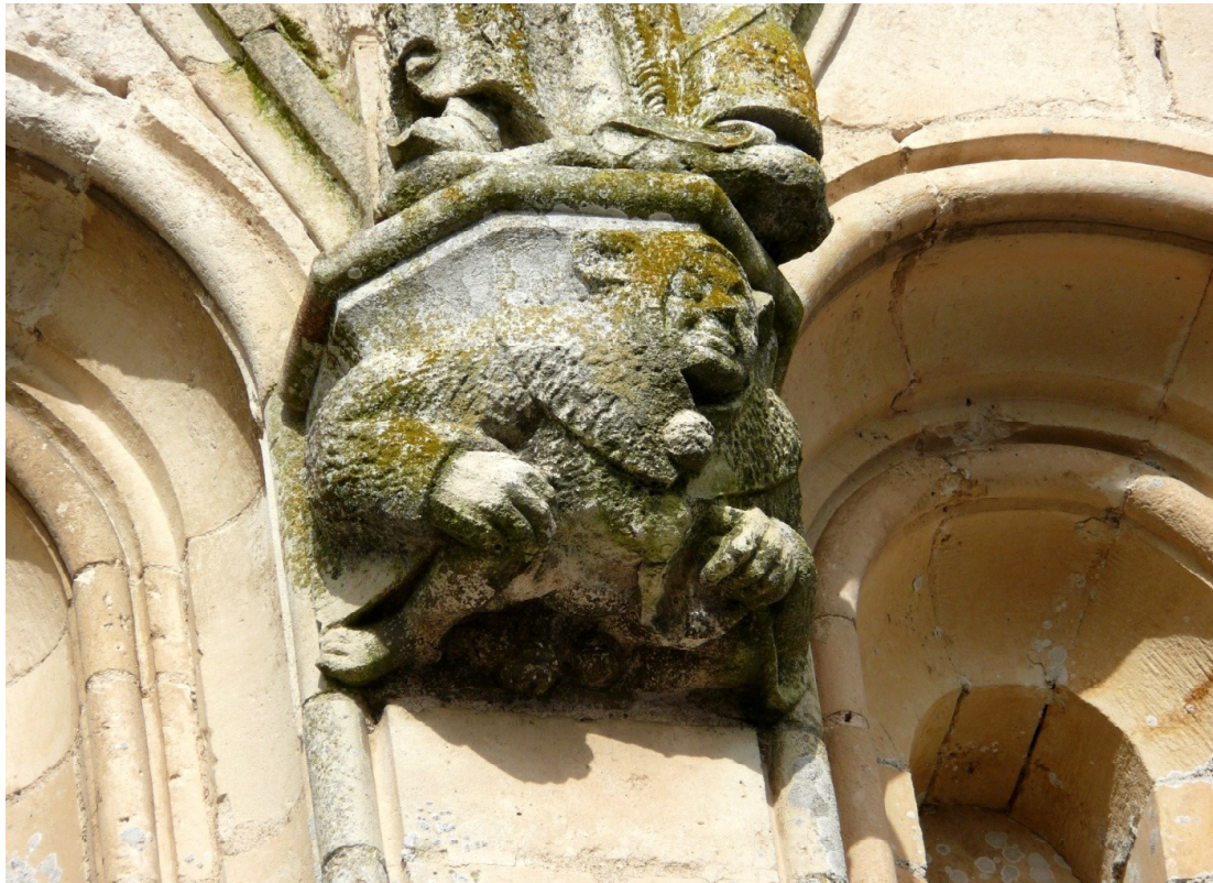
23- Église Notre-Dame, face ouest : console du saint Martin de Tours, diablotin impudique (14.03.2024).© L. Cazaubon
