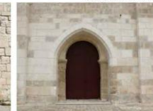
Portail Nord après restauration (2024)
