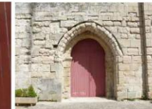
Portail Nord avant restauration (2022)
