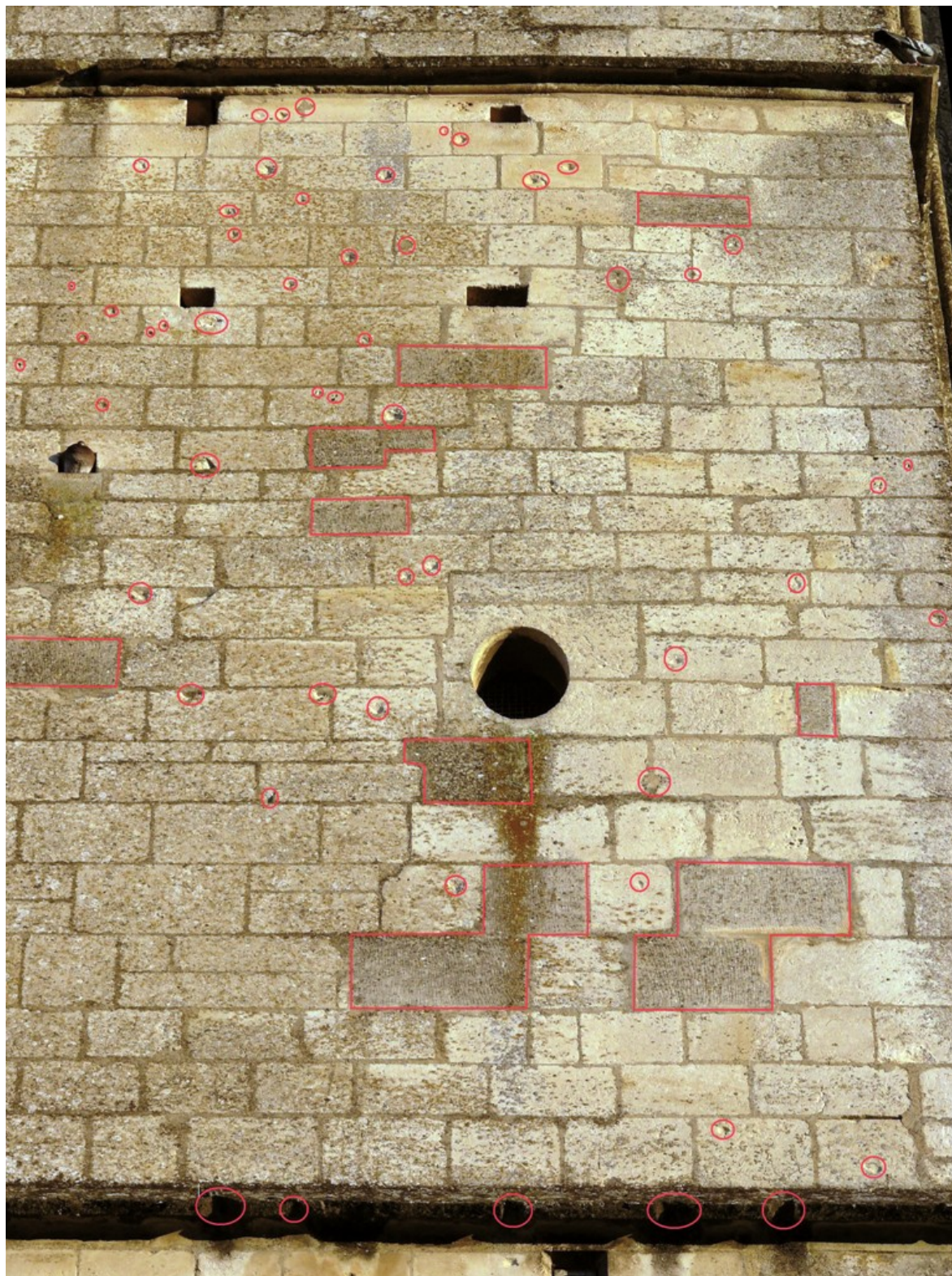
6. Face ouest – Escalier – Fenêtre 6 (oculus) – © L. Cazaubon
