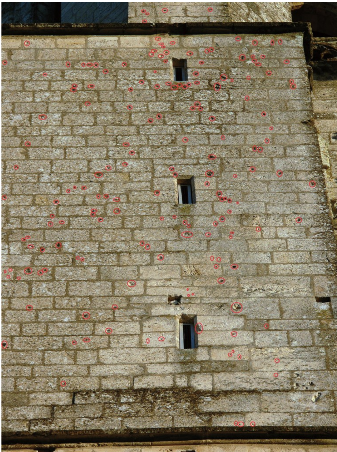
5. Face ouest – Escalier – Fenêtres 9, 8, 7 (en partant du haut) © L. Cazaubon
