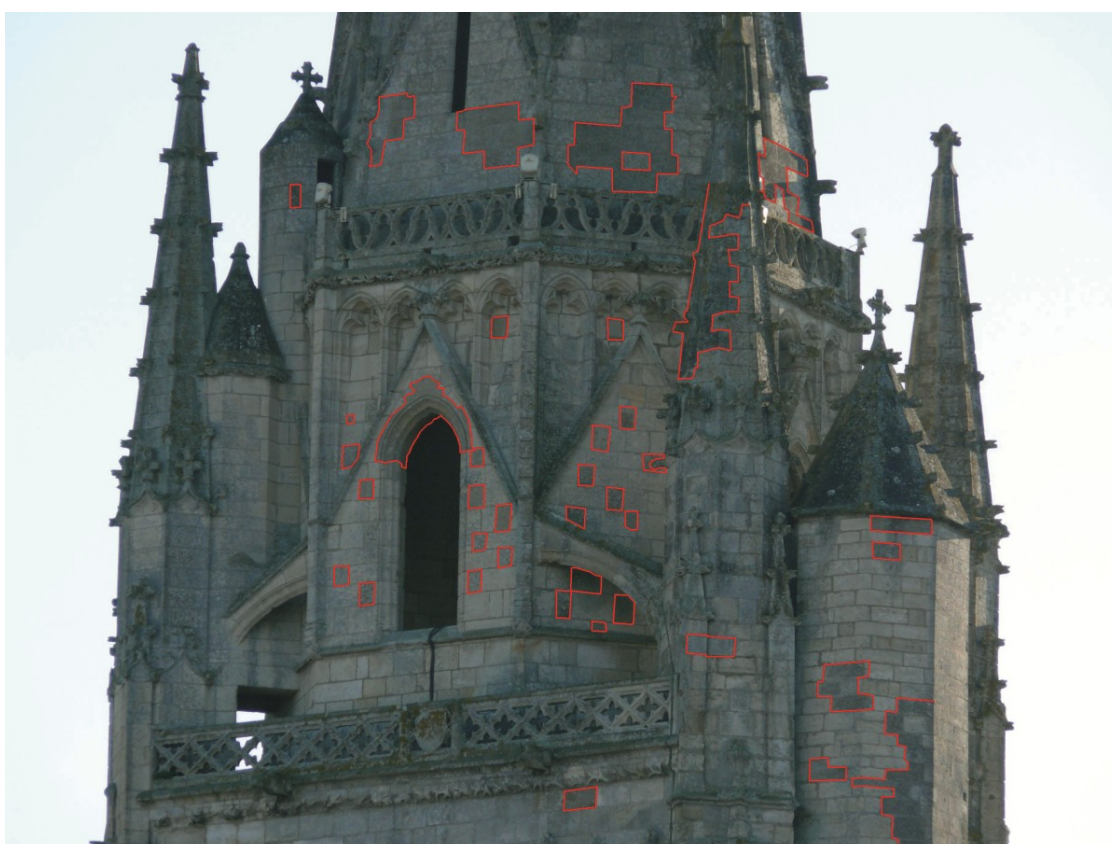
14. Clocher Face nord : traces des campagnes successives de réparations. Sur la vis : traces des réparations de 1584 et 1603 © L. Cazaubon
