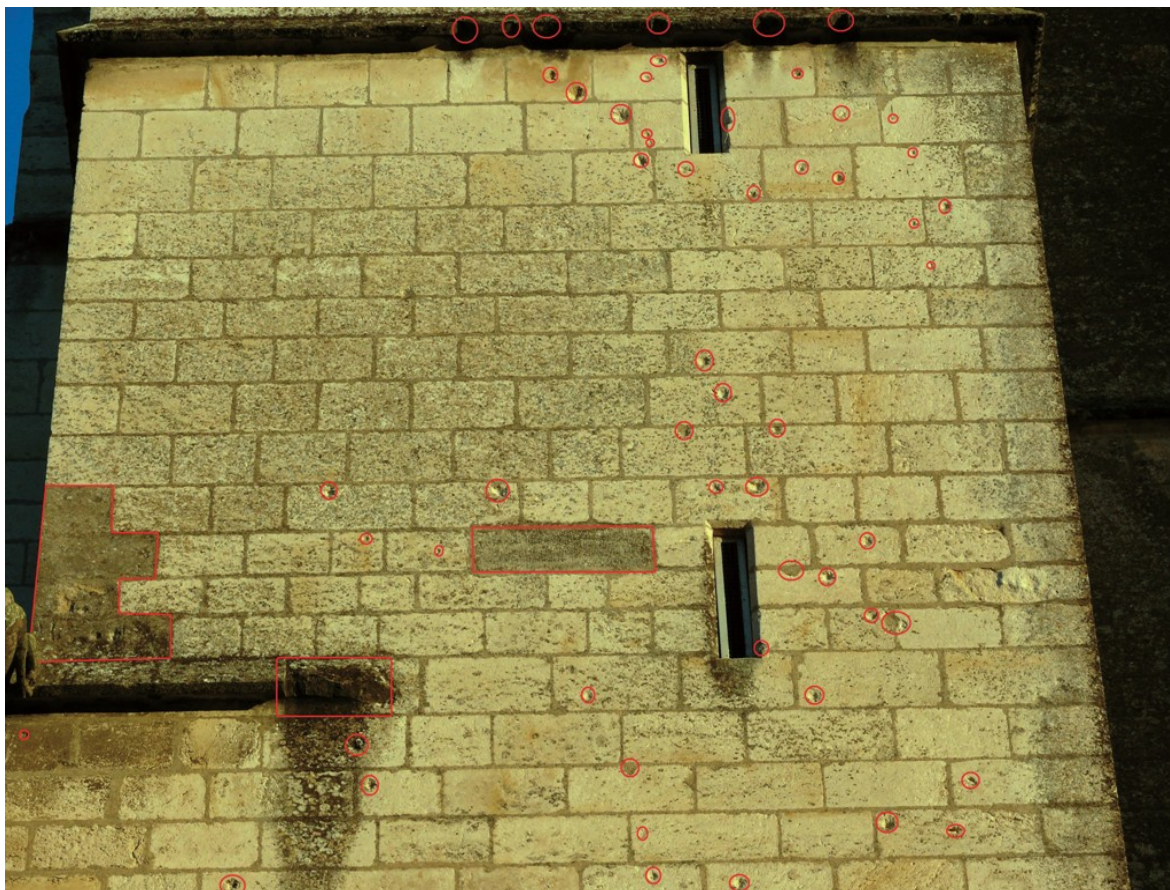
7. Face ouest – Escalier – Fenêtres 5, 4 (en partant du haut) – © L. Cazaubon
