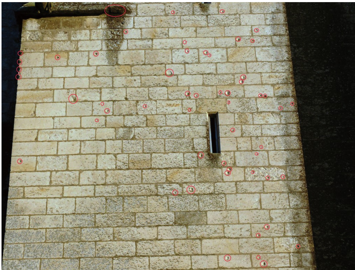
9. Face ouest – Escalier – Fenêtre3 – © L. Cazaubon
