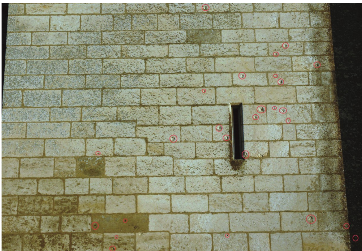
10. Face ouest – Escalier – Fenêtre2 – © L. Cazaubon
